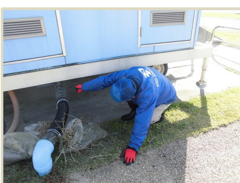
桜堤サブセンター
